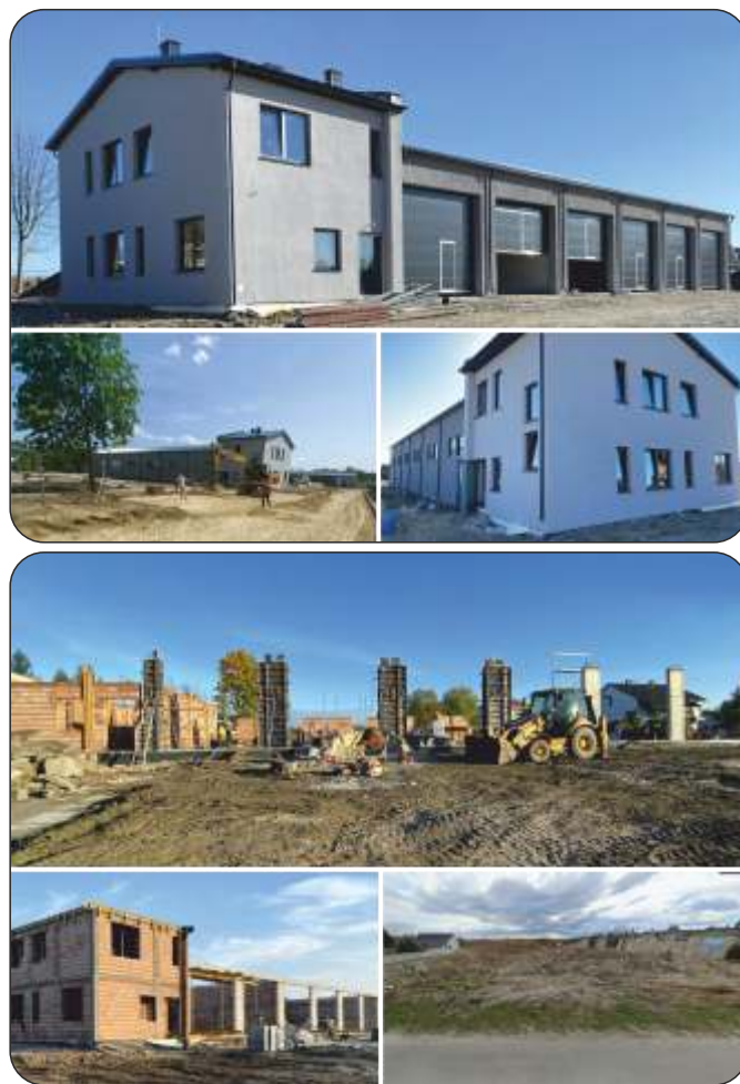
PSZOK w budowie
