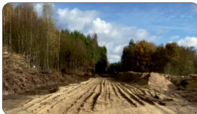
Odcinek oleśnickiej obwodnicy (Wojnow-Oleśnica)
