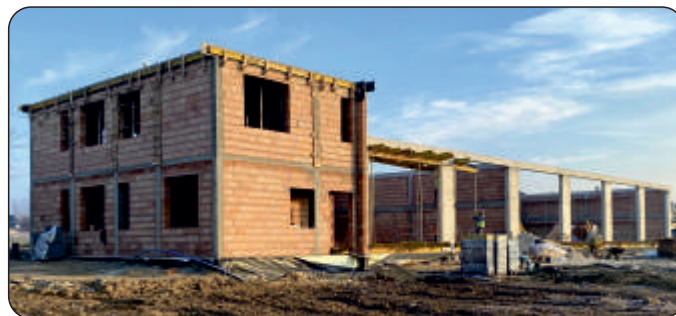
Budynek PSZOK-u w budowie
