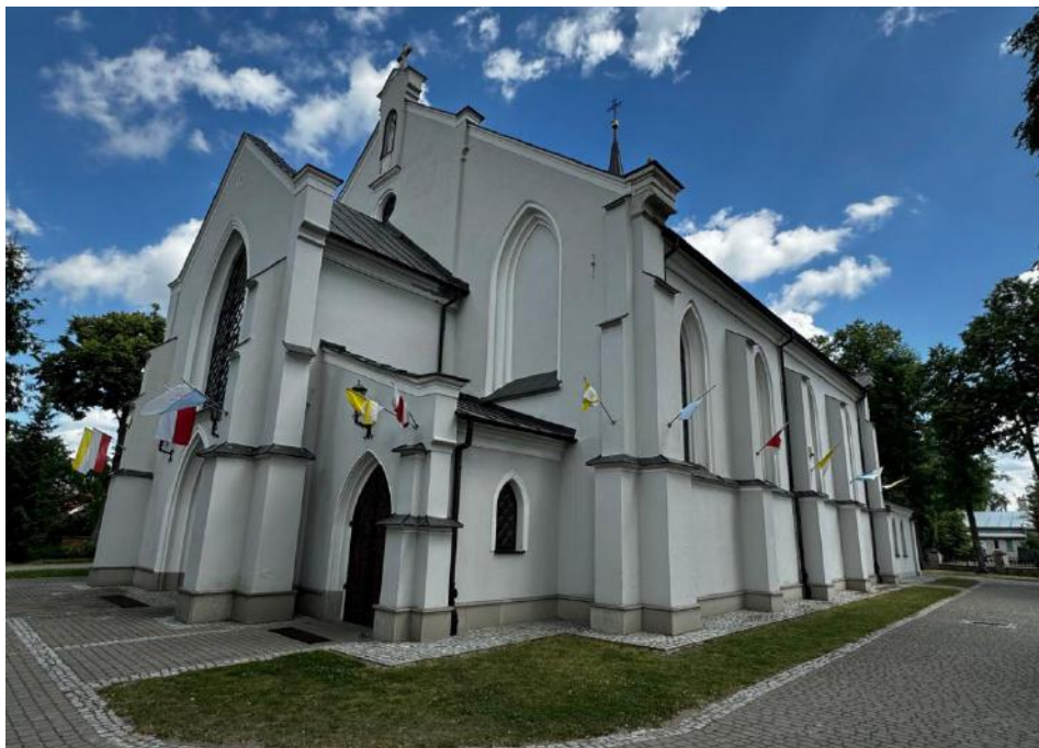
Fot. 2 – Widok kościoła (2024 r.) Źródło: własne
