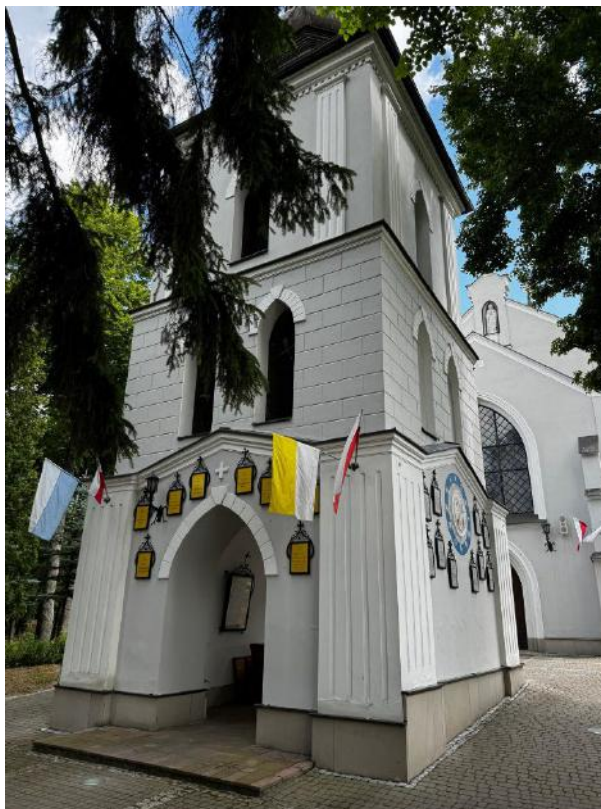
Fot. 8 – Elewacja wschodnia oraz północna dzwonnicy. Źródło: własne
