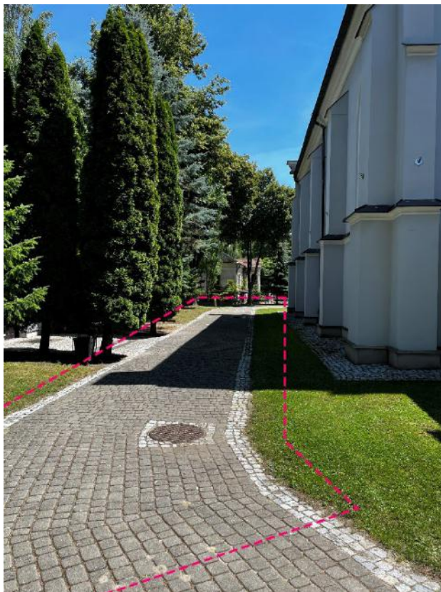
Fot. 24 – Zakres remontu utwardzenia przy kościele, przy elewacji północnej. Źródło: własne
