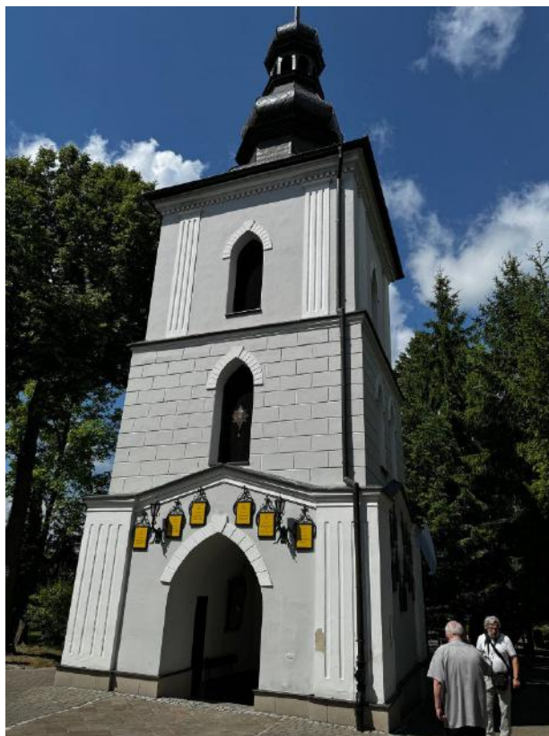
Fot. 9 – Elewacja zachodnia dzwonnicy. Źródło: własne
