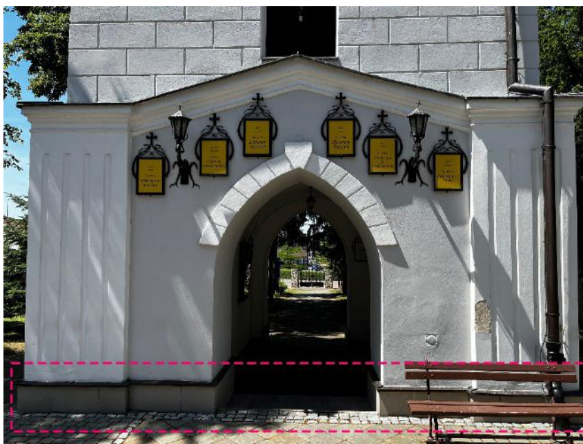
Fot. 13 – Cokół dzwonnicy do renowacji. Źródło: własne
