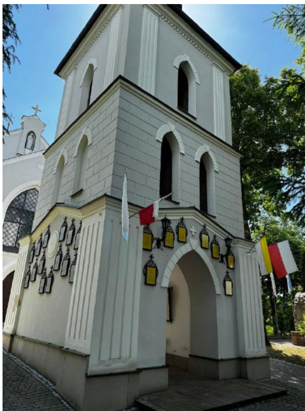
Fot. 7 – Elewacja wschodnia oraz południowa dzwonnicy. Źródło: własne
