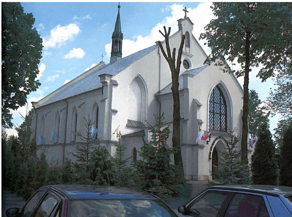
Fot. 5 – Elewacja wschodnia i północna kościoła. Źródło: „Projekt remontu kościoła w Oleśnicy w zakresie: wymiana posadzki i pokrycia dachowego”
