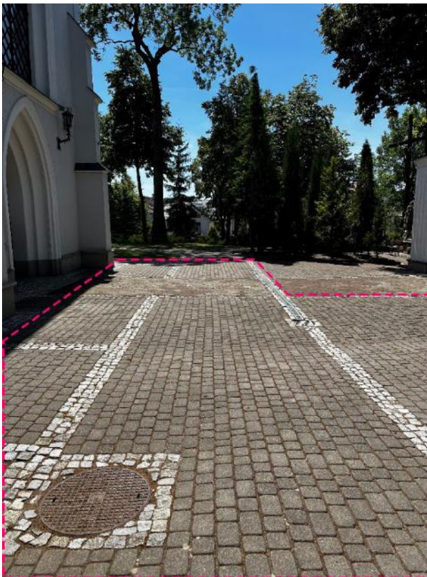
Fot. 25 – Zakres remontu utwardzenia przy kościele, przy elewacji wschodniej. Źródło: własne
