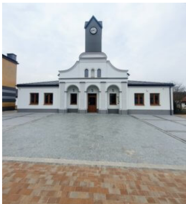
Budynek po modernizacji
