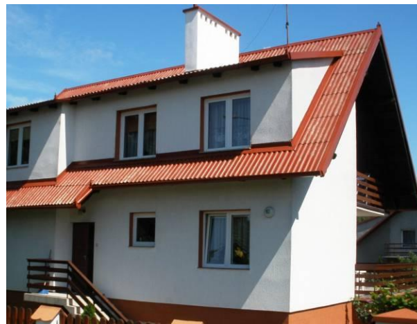
Rys. 5. Przykład zabezpieczenia wykonanego powłoką malarską.
